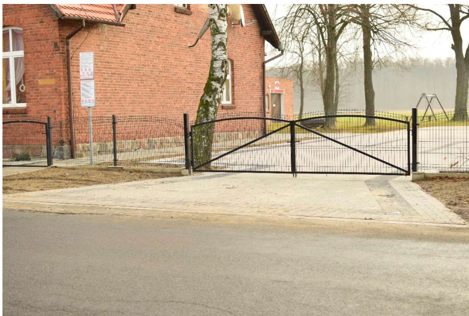
Utwardzenie placu przy świetlicy wiejskiej w Ludwinowie
