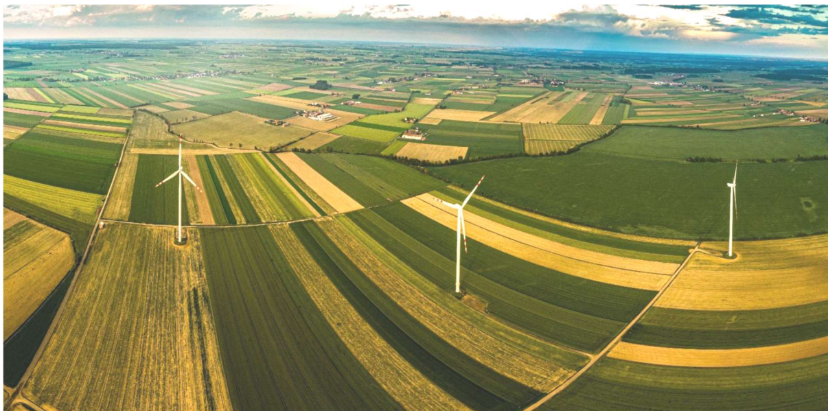
Fotografia 2. Widok farm wiatrowych zlokalizowanych na terenie gm. Pępowo
