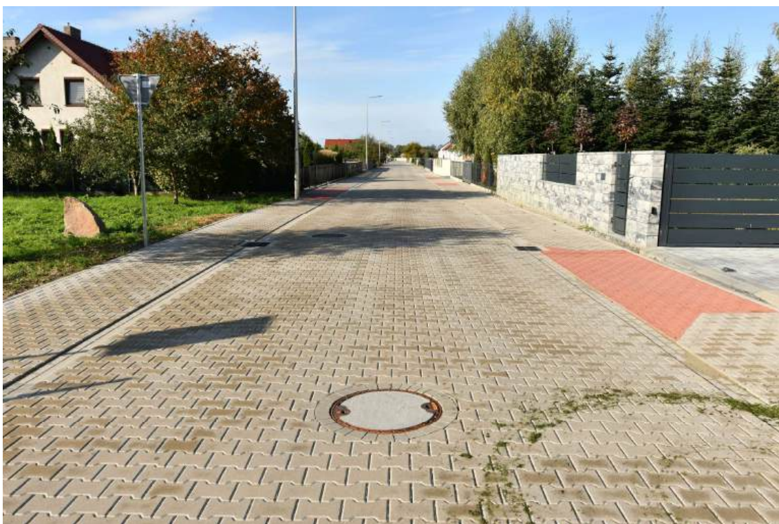
Fot. 7 i 8. Budowa ulicy Wiejskiej, Rolniczej, Ogrodowej, Żniwnej, Kwiatowej i Konarzewskich w m. Pępowo wraz z infrastrukturą – etap II
