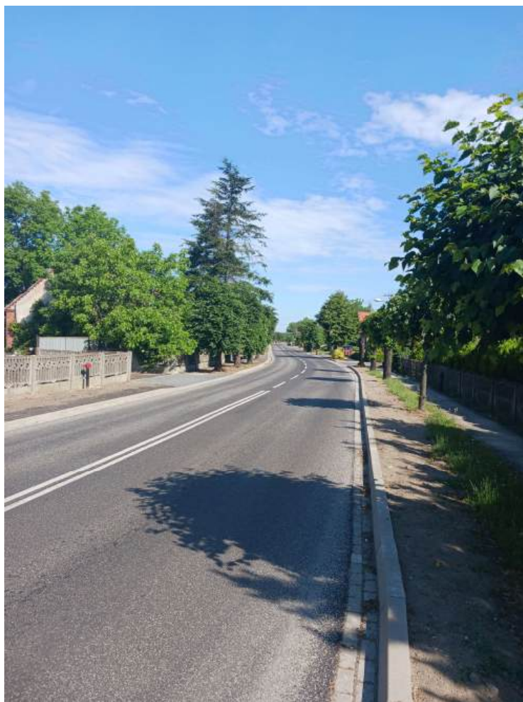
Fot. 2. Droga powiatowa nr 4953P w miejscowości Babkowie
