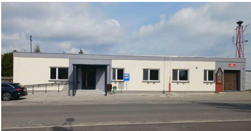
Fot. 15. Przebudowa świetlicy wiejskiej w Krzekotowicach
