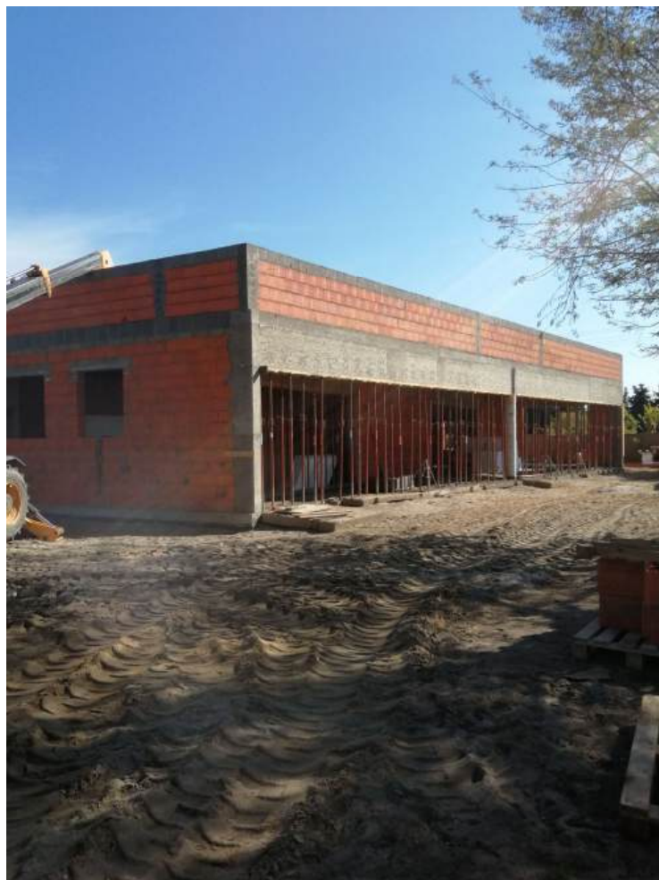
Fot. 9 i 10. Budowa żłobka gminnego w Pępowie
