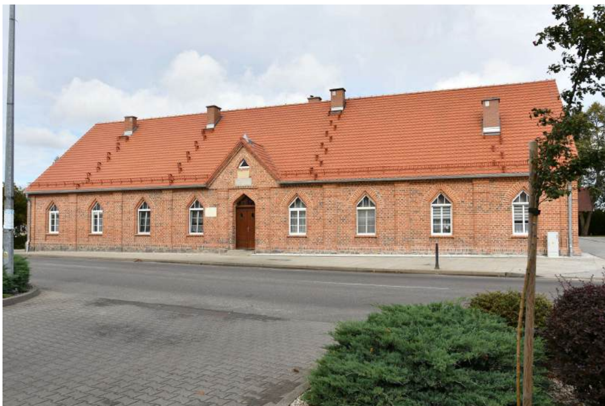
Fot. 3 i 4. Wielorodzinny budynek komunalny “Szpitalik” (przed i po renowacji)
